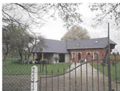
Longère en brique au hameau du Carré, avec extension nouvelle.
