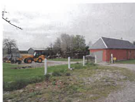
Une entreprise de maçonnerie, située au hameau du Carré, illustrant l'importance de la filière de la construction dans la commune.
