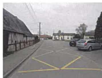
Espaces publics et stationnements en centre-bourg à proximité immédiate des équipements.
