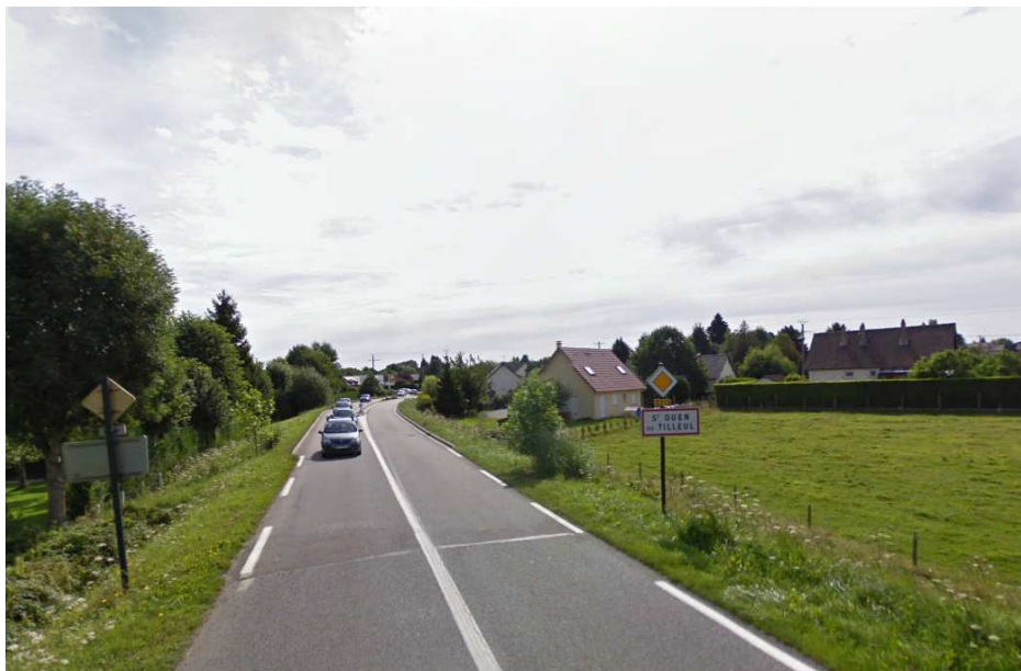
Entrée Nord de Saint Ouen du Tilleul (RD 313 en direction d'Elbeuf)
