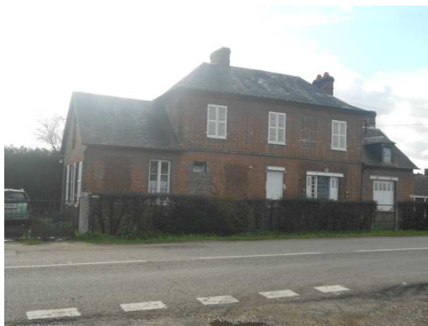
Maison de maître dans le bourg de Saint Ouen du Tilleul
