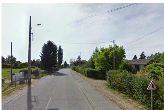
Trottoir le long de la rue de la Mairie
