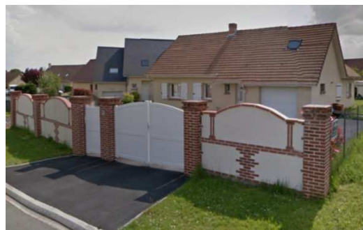
Portail en PVC et mur enduit et briques flammées rue des Faudits
