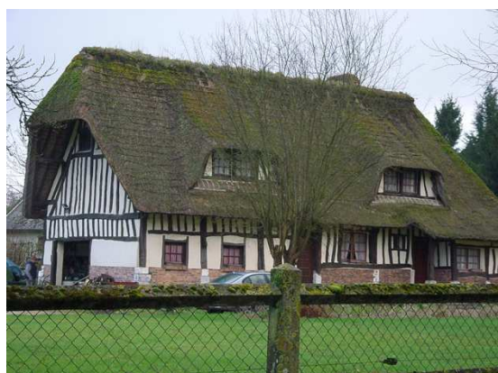
Chaumière en périphérie du hameau Les Déserts
