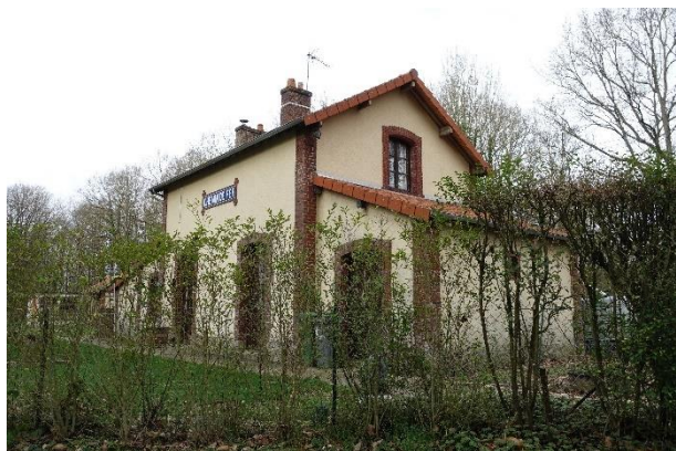
10 : Ancienne gare et 11 : Tunnel maçonné
