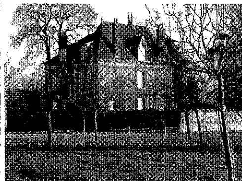
Une construction de la Noë...
