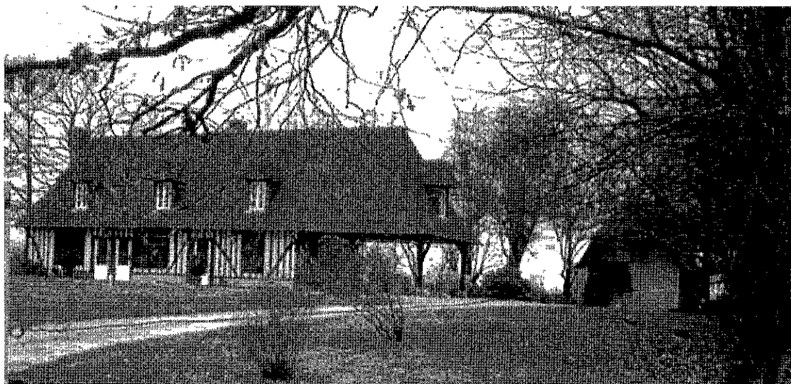
Construction réhabilitée à la Gioterie
