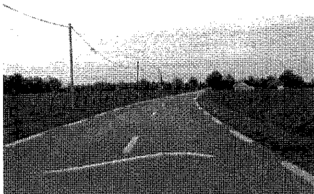
Entrée Est du Village le long de la RD137
