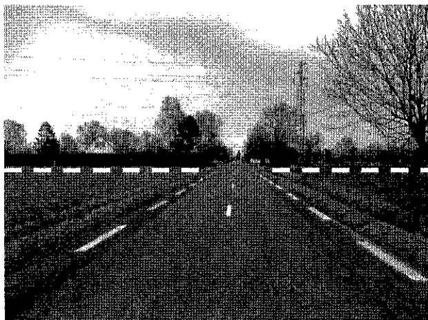
Entrée Ouest de la RD137 : limite de la zone constructible marquée à gauche par la dernière construction et à droite par le chemin rural n°23, bordé de talus planté.
