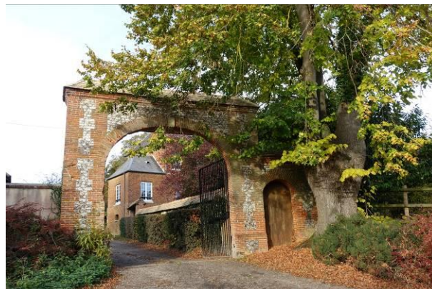
Portail et maison à conserver
