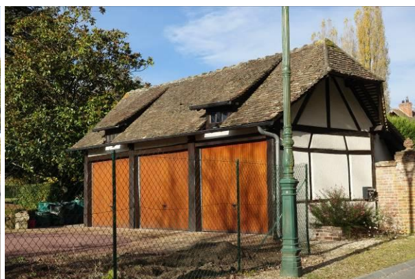
Constructions à conserver
