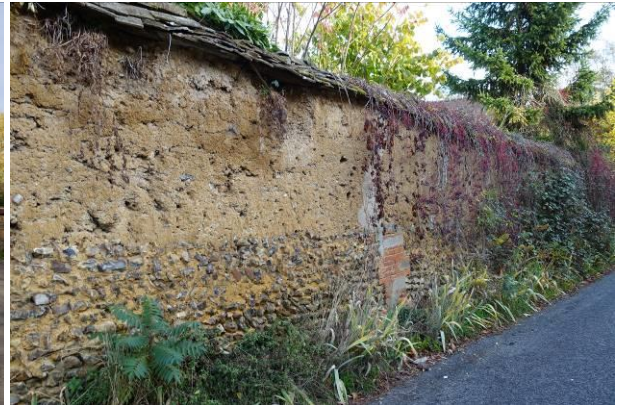
Murs de clôture à conserver
