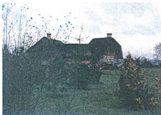
Figure 60ter : Construction neuve authentique de qualité mais volume imposant (La Sablonnière)
