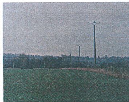
Figure 40 : Réseaux aériens sur le plateau agricole
