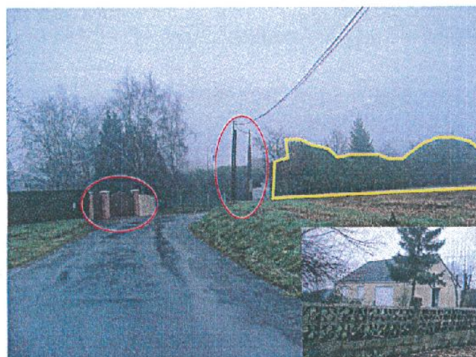
Figure 53 : L'entrée Sud du bourg par la VC5 : des limites franches mais des clôtures à harmoniser
