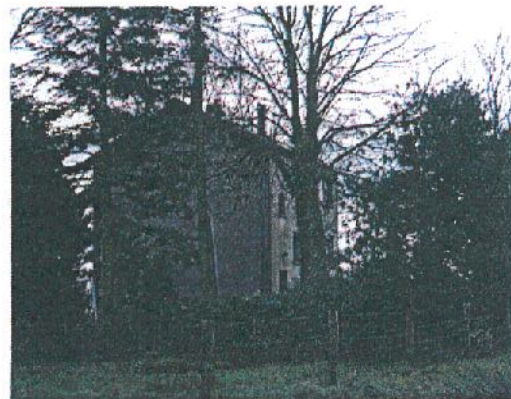
Figure 65 : Habitation à un étage à La Prud'homme
