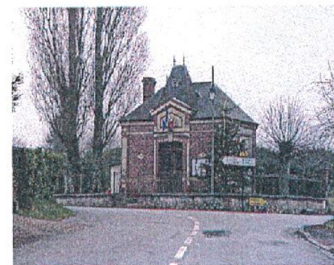
Figure 6 : Mairie de Saint-Benoist-des-Ombres
