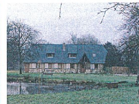
Figure 60bis : Construction neuve authentique : volume et matériaux traditionnels (pans de bois, soubassement de pierres calcaires et silex), lucarnes bien proportionnées ; seuls les volets blancs en PVC dénotent
