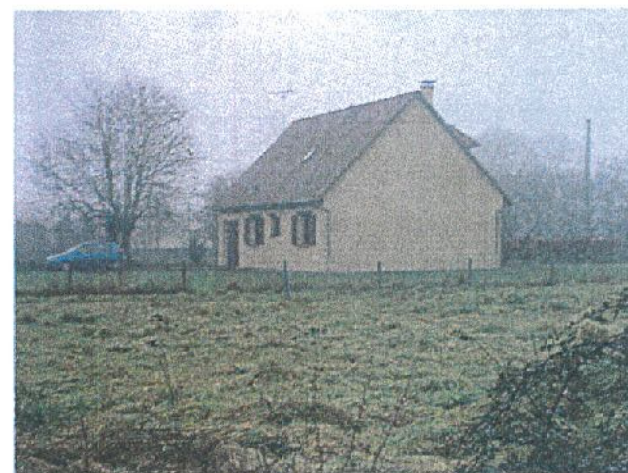
Figure 63 : Pavillon neuf standard construit en 2004 : volume simple, pignon plein et aveugle, tuiles mécaniques
