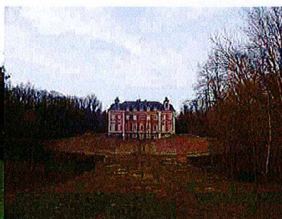
La façade sud (vue lointaine)
