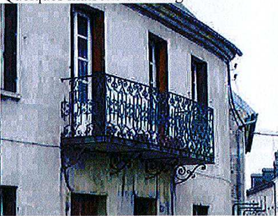
Un balcon avec ferronneries (détail)
