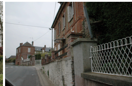
Constructions en brique rouge du pays dans le centre du village
