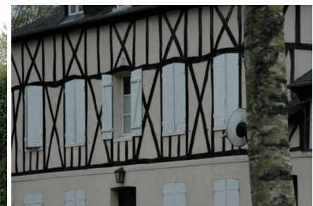
Construction ancienne à pans de bois
