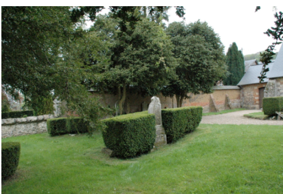
Mur en appareillage de pierres locales et en bauge (cimetière)
