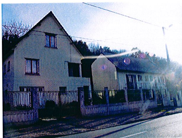
Le long de la section nord de la RN 321
