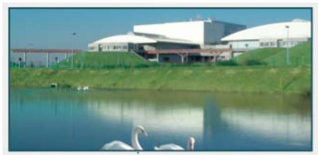
L'usine d'incinération de Guichainville
