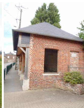
Élément n°16 : ancien local des pompiers
