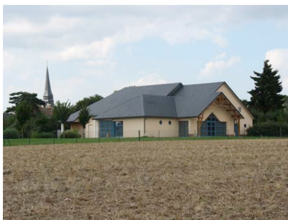
La salle des fêtes vue depuis les espaces agricoles
