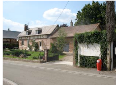
Bâti ancien en retrait rue Gosse
