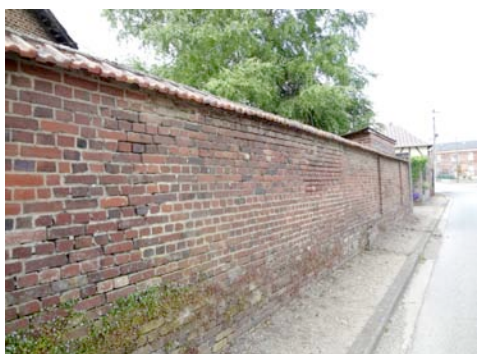
Élément n°17 : Mur rue du Bout du Bas
