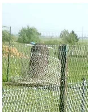
Élément n°25 : Pompe et cuve rue Gosse
