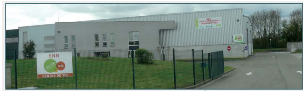
Centre de tri des déchets recyclables d'Étrépagny
