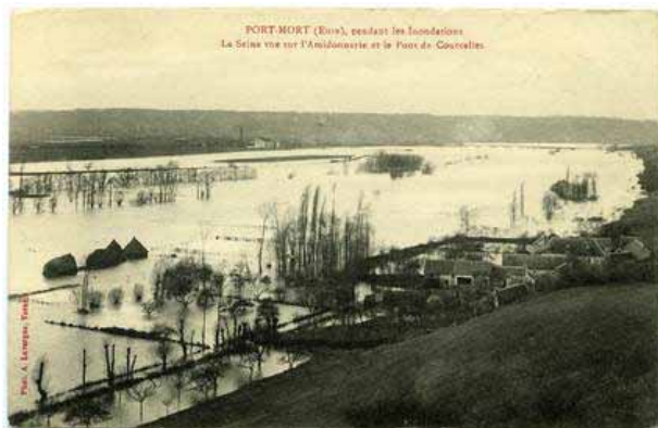
Port-Mort, pendant les Inondation (la crue 1910)- La Seine, Vue sur l'Amidonnerie et le Pont de Courcelles. (source: Archives départementales Eure)
