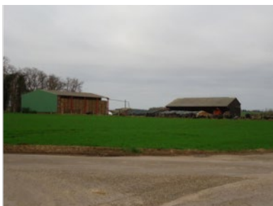
Hangar de stockage situé Rue du Petit Breuil
