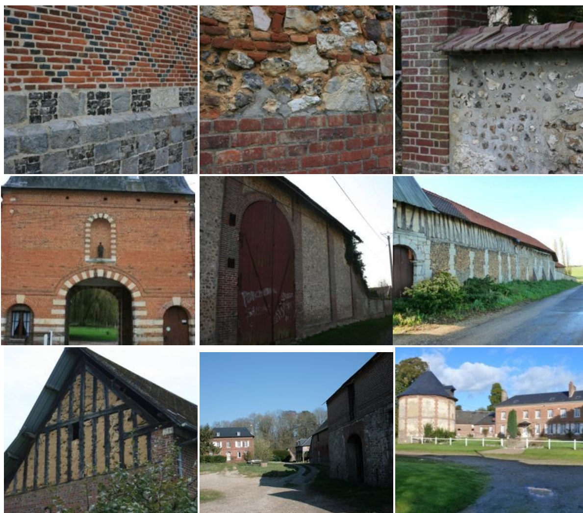
Des matériaux traditionnels qualifiant le bâti et le patrimoine architectural : pan de bois, brique, silex...
