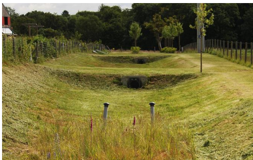
Exemple : Bassin d'infiltration (Source : Photothèque CAUE 27)
