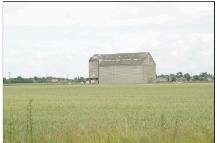
Silo à grains de Moisville : une silhouette imposante dans ce paysage horizontal. (2010 - commune de Moisville)
