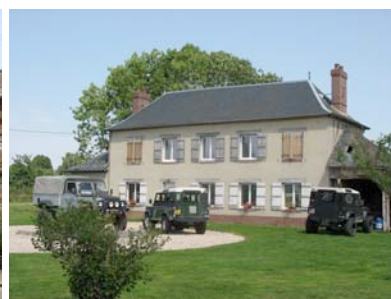
Bâti ancien en retrait
