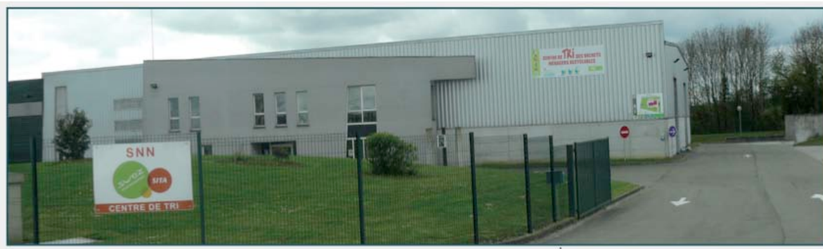
Centre de tri des déchets recyclables d'Étrépagny
