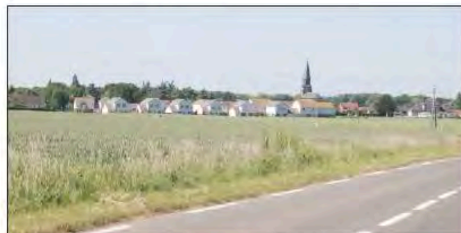
Village d'Huest : une extension récente qui se juxtapose au village ancien. (2010)
