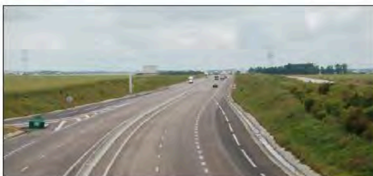
Une route dont les abords sont peu aménagés et dont les ouvertures visuelles sur le territoire sont rares.
