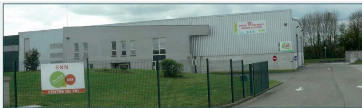
Centre de tri des déchets recyclables d'Étrépagny
