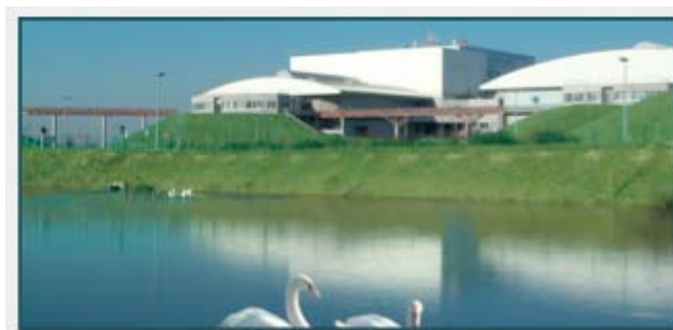
L'usine d'incinération de Guichainville
