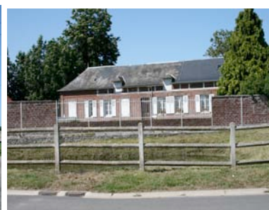
Bâti ancien en retrait
