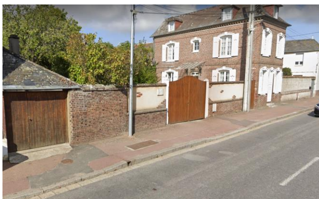
Mur maçonné enduit, avenue du Doyen Jussiaume (83)
