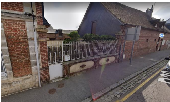
Mur-bahut maçonné, avenue de la libération (60)
