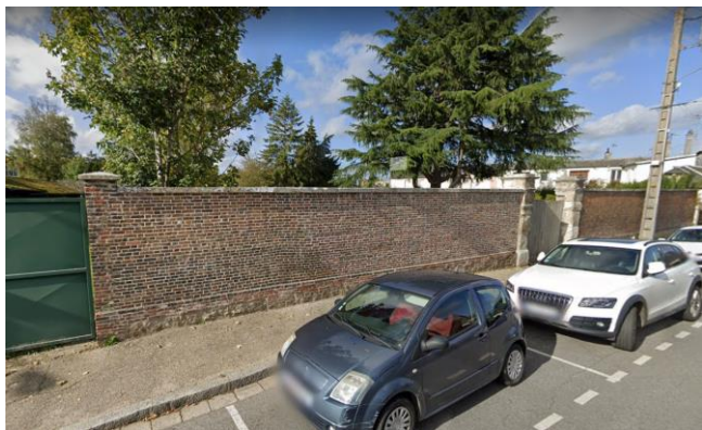
Mur maçonné, rue de Verdun (76)
