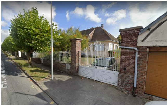
Mur-bahut maçonné, avenue du Doyen Jussiaume (89)
