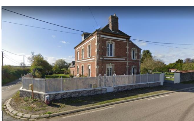
Mur-bahut maçonné, avenue de Lattre de Tassigny (95)
