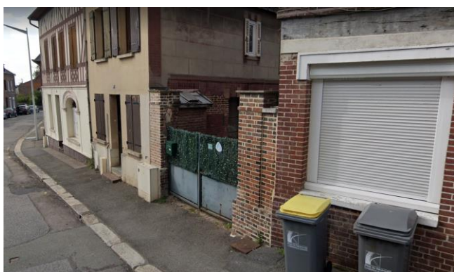
Mur maçonné et portail (doublage peu qualitatif), rue Henri Dunant (32)
