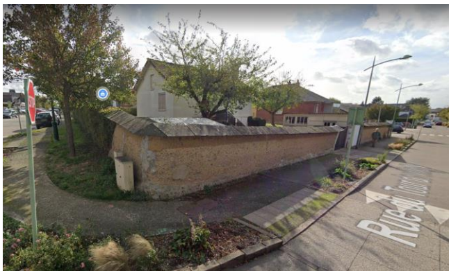
Mur en bauge, rue du Tour de ville Nord (18)
