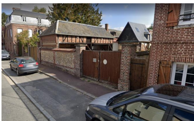
Mur maçonné, avenue du Doyen Jussiaume (84)
