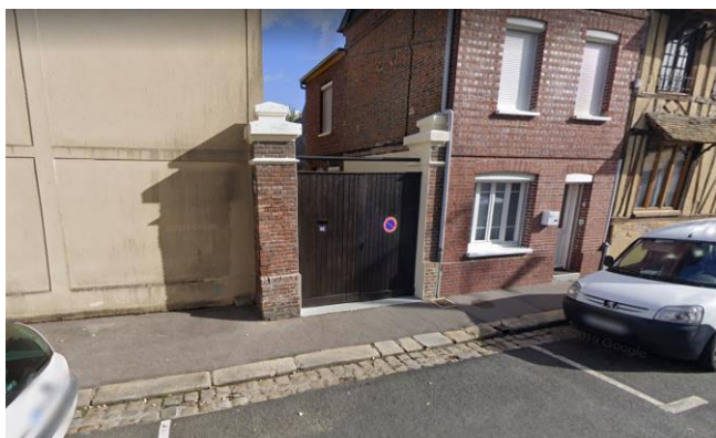
Mur maçonné et portail, rue Octave Bonnel (55)
