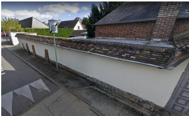
Mur maçonné enduit, rue du Tour de ville Nord (20)
