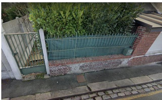
Mur-bahut maçonné, rue du Dr Couderc (6)
