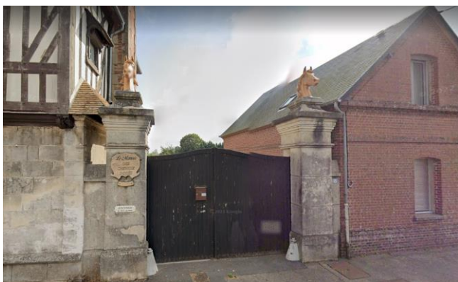
Mur maçonné et portail, avenue de la libération (70)
