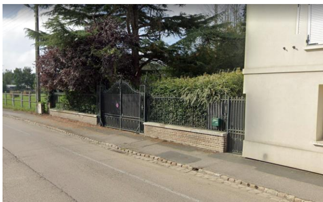
Mur-bahut maçonné, avenue de la libération (69)
