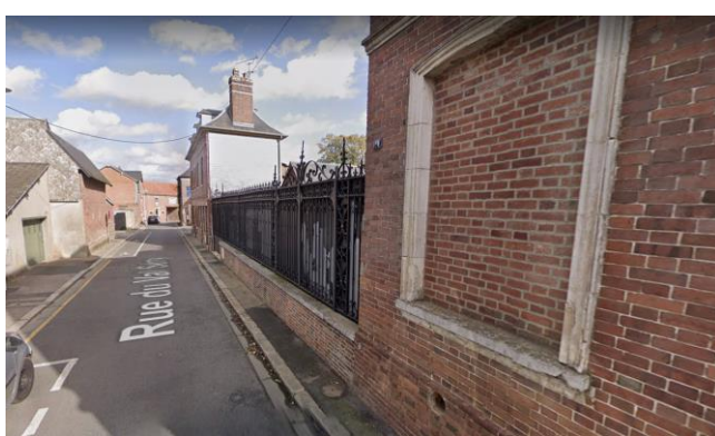
Mur-bahut maçonné, rue du Val Séry (49)
