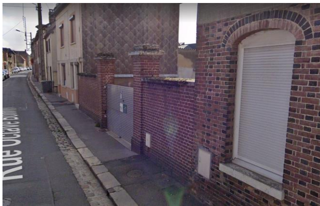
Mur maçonné, rue Octave Bonnel (54)
