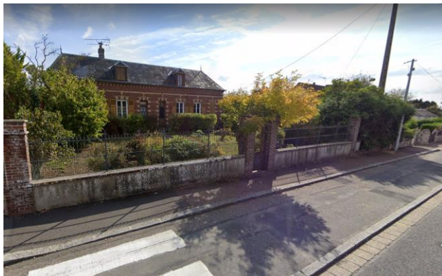
Mur-bahut enduit, avenue du Doyen Jussiaume (79)
