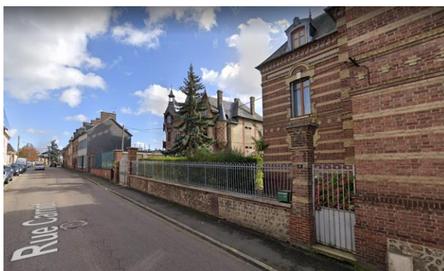
Mur-bahut maçonné, rue Carnot (41)
