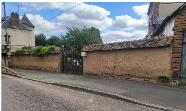
Mur en bauge, rue du Champ de Bataille (97)
