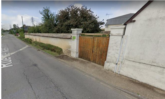
Mur maçonné enduit, rue de Nassandres (33)
