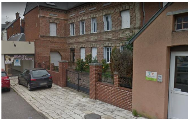
Mur-bahut maçonné, place de la Mare des Fossés (38)
