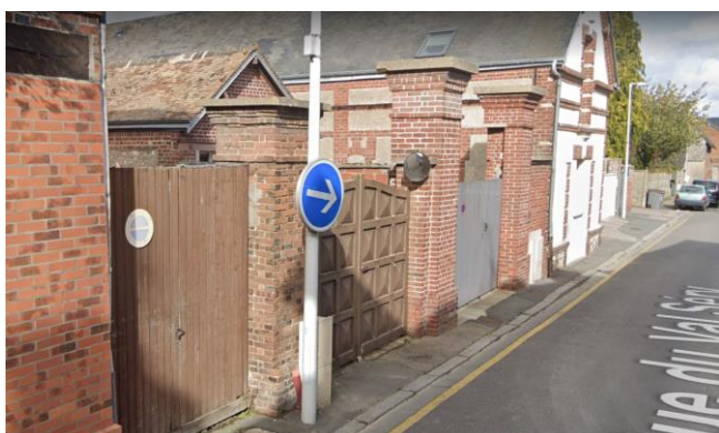
Mur maçonné et portail, rue du Val Séry (52)
