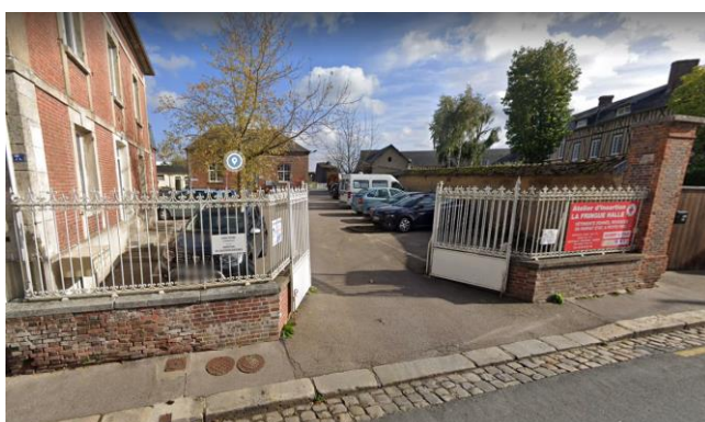
Mur-bahut maçonné, rue Octave Bonnel (56)
