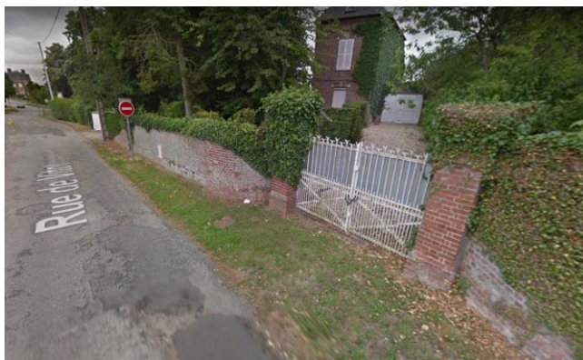
Mur maçonné, rue de Vitot (91)
