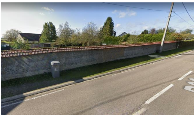
Mur en bauge, avenue de Lattre de Tassigny (96)
