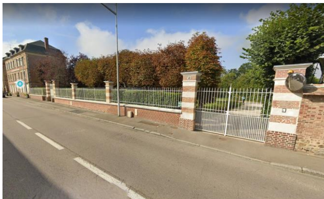
Mur-bahut maçonné, avenue de la libération (67)
