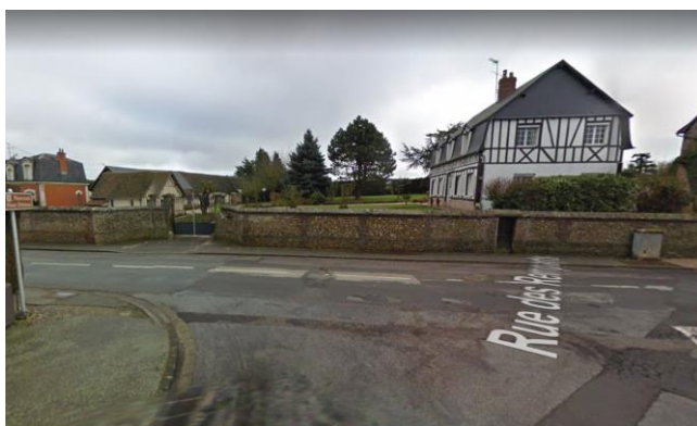
Mur maçonné, rue de Brionne (21)
