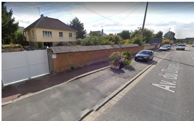
Mur en bauge (ciment !), avenue du Doyen Jussiaume (82)
