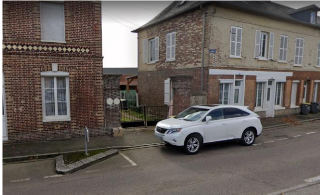
Mur maçonné et portail, rue carnot (47)
