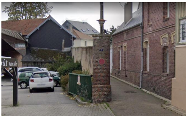
Mur maçonné enduit, rue du Marché aux Fruits (40)
