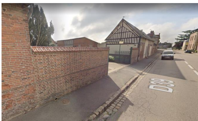
Mur maçonné, avenue de la libération (66)
