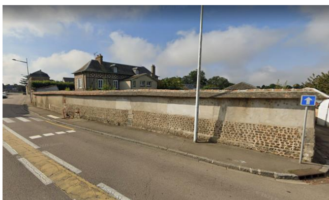
Mur maçonné enduit, avenue de la libération (64)
