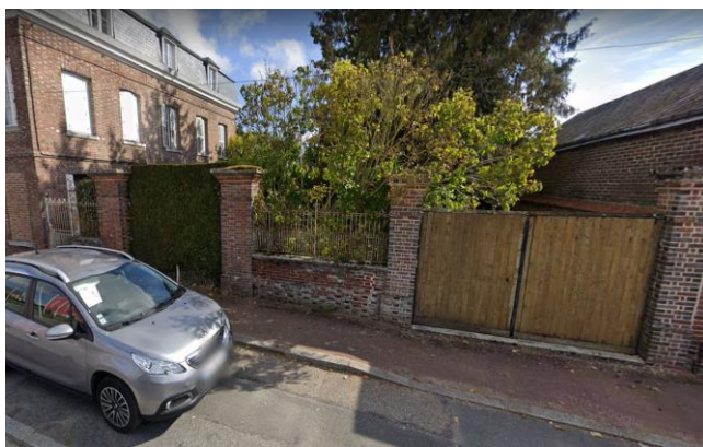
Mur-bahut maçonné, avenue du Doyen Jussiaume (85)
