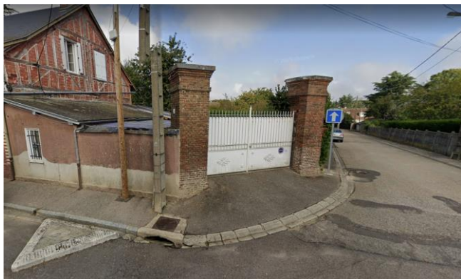
Mur maçonné et portail, rue de Brionne (26)
