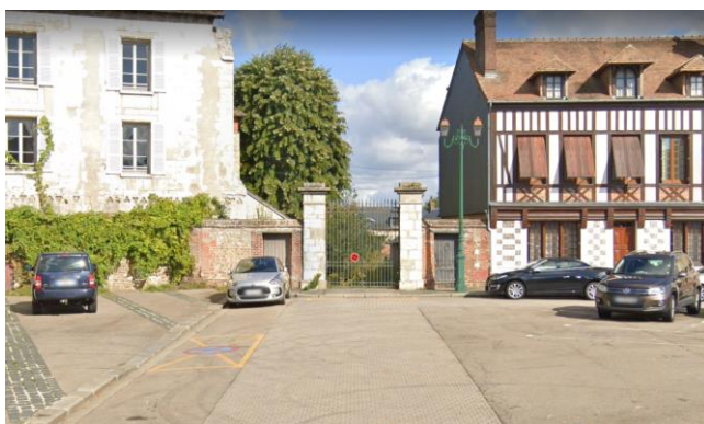
Mur maçonné et portail, place du château (2)
