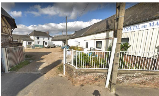
Mur-bahut maçonné (grille peu qualitative), rue Octave Bonnel (58)
