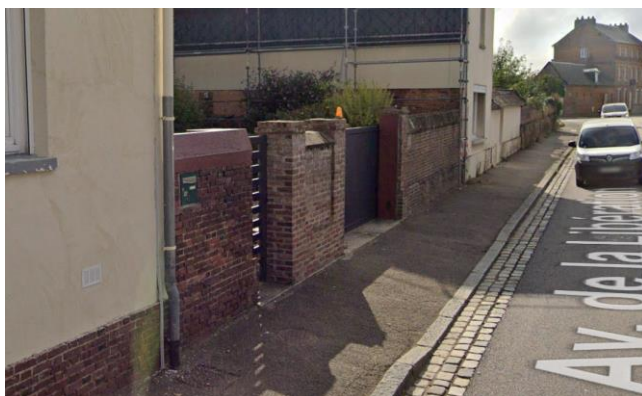
Mur maçonné, avenue de la libération (61)
