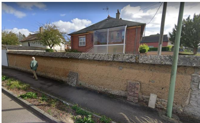
Mur en bauge, rue du Tour de ville Nord (19)
