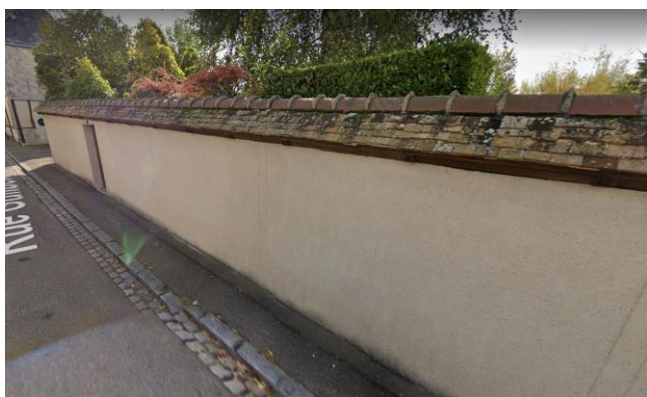
Mur maçonné enduit, rue Guilbert (12)
