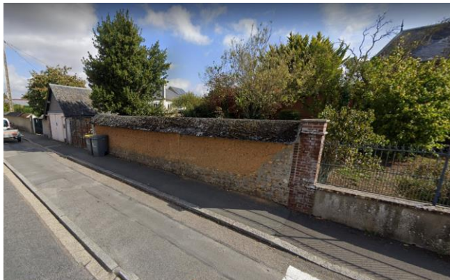
Mur en bauge, avenue du Doyen Jussiaume (80)
