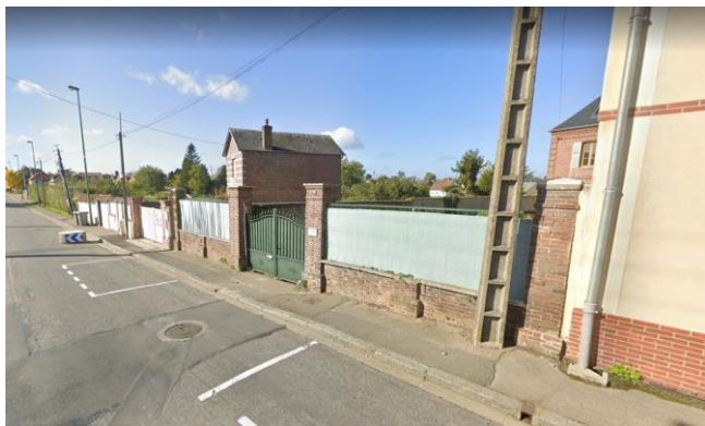
Mur-bahut maçonné (doublage peu qualitatif), route de Beaumont (36)
