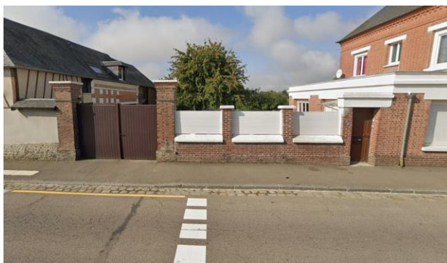
Mur-bahut maçonné, avenue de la libération (63)
