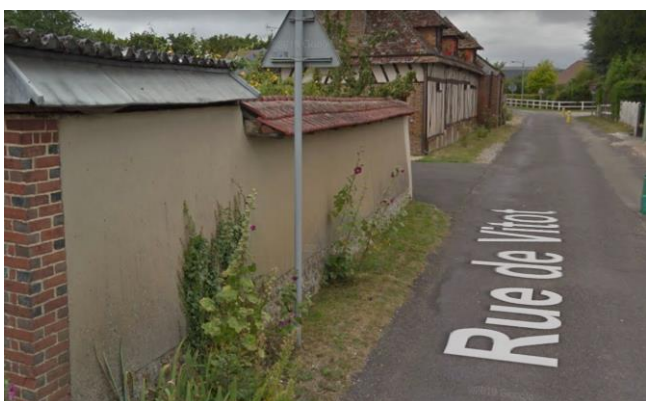
Mur en bauge, rue de Vitot (94)
