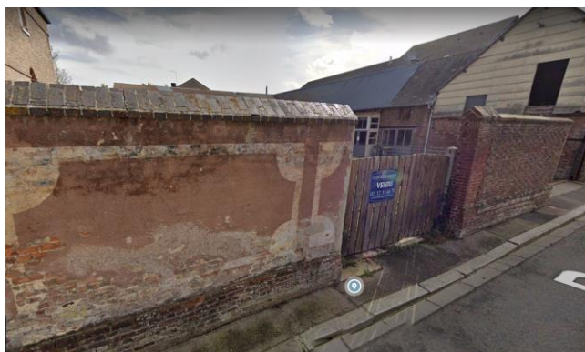
Mur maçonné, rue du Val Séry (51)
