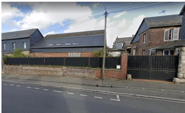
Mur-bahut maçonné, rue du Champ de Bataille (5)
