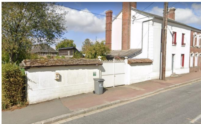
Mur maçonné enduit, avenue du Doyen Jussiaume (81)
