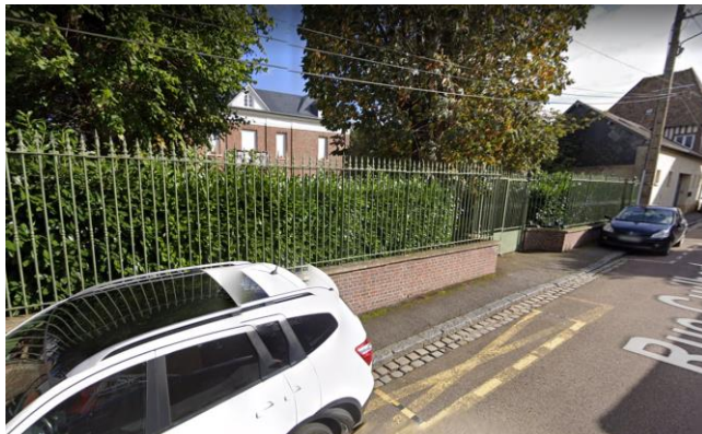
Mur-bahut maçonné, rue Guilbert (13)
