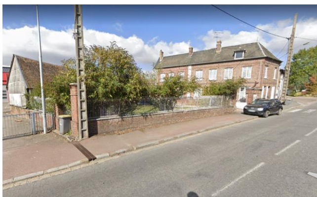
Mur-bahut maçonné, avenue du Doyen Jussiaume (87)
