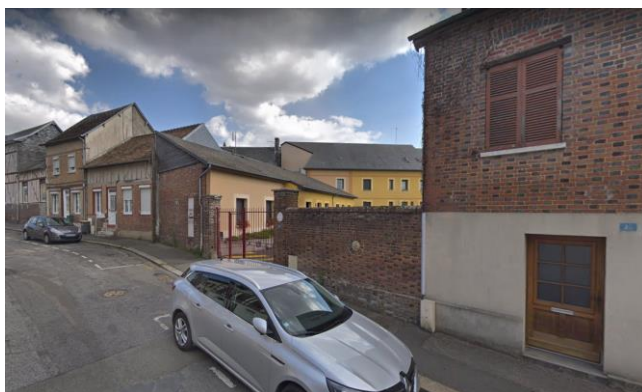
Mur maçonné et portail, rue Henri Dunant (31)
