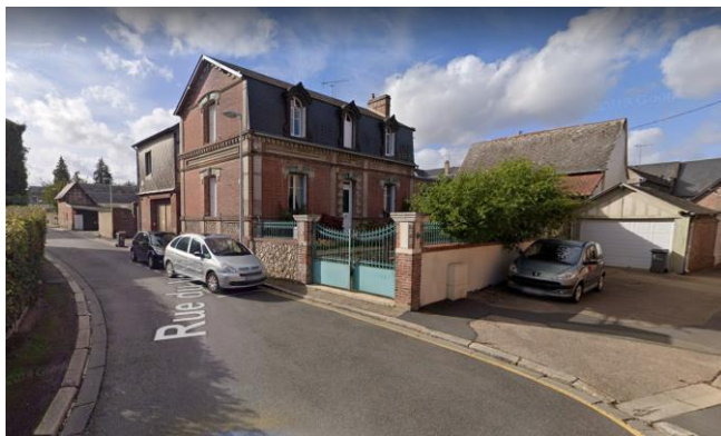
Mur-bahut maçonné, rue du Val Séry (48)
