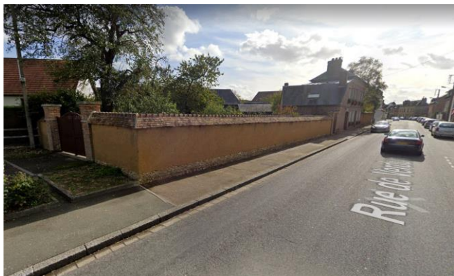
Mur en bauge, rue de Verdun (1)
