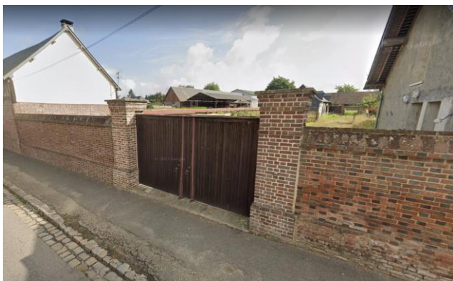
Mur maçonné, avenue de la libération (68)
