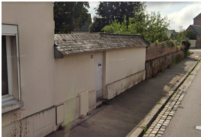
Mur maçonné, avenue de la libération (62)
