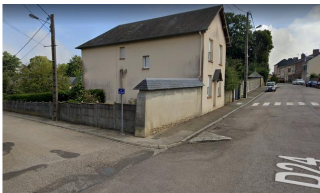
Mur maçonné enduit, rue de Brionne (27)
