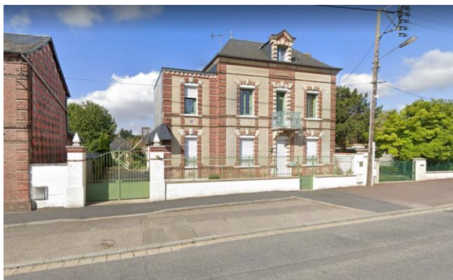
Mur-bahut enduit, avenue du Doyen Jussiaume (78)
