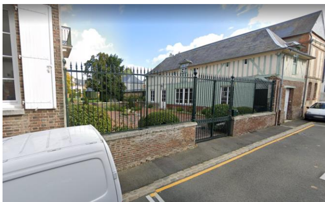
Mur-bahut maçonné, rue du Dr Couderc (8)
