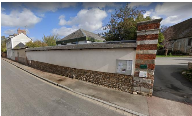
Mur maçonné enduit, rue de Verdun (74)
