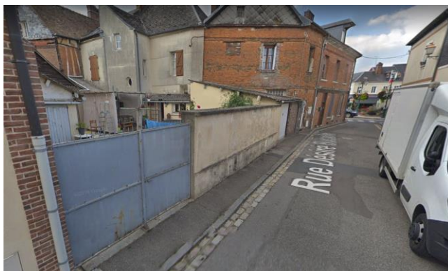
Mur maçonné enduit, rue Désiré Bucaille (39)
