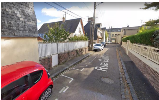
Mur-bahut maçonné, rue Guilbert (15)
