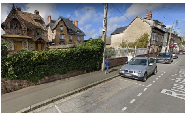
Mur-bahut maçonné, rue de Verdun (75)
