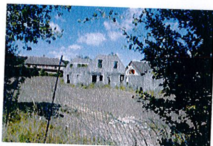
Habitations récentes en construction, dans le tissu urbain
