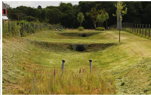
Exemple : Bassin d'infiltration (Source : Photothèque CAUE 27)
