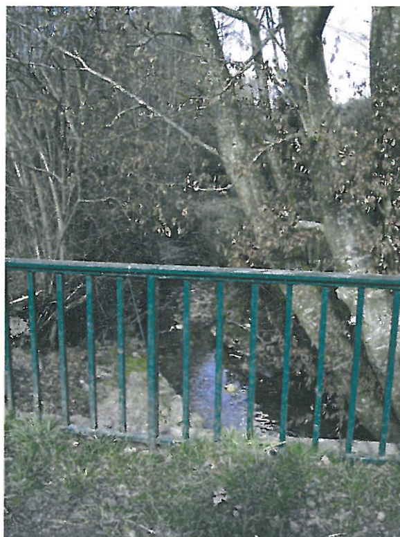
ouvrage sur la Corbie
