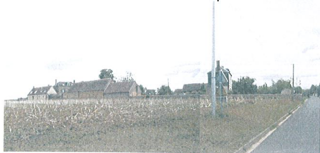
vue de l'arrière d'un bâtiment ancien près du cimetière
