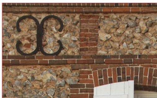
Maçonnerie de brique et silex.
