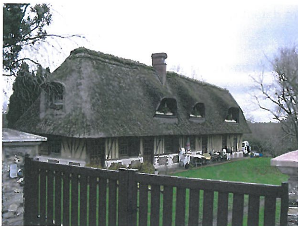
Figure 51: Chaumière Rue de la Mare Curée
