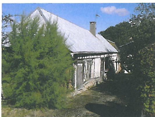
Figure 4: Habitation vacante sur la Rue de la Mare Curée
