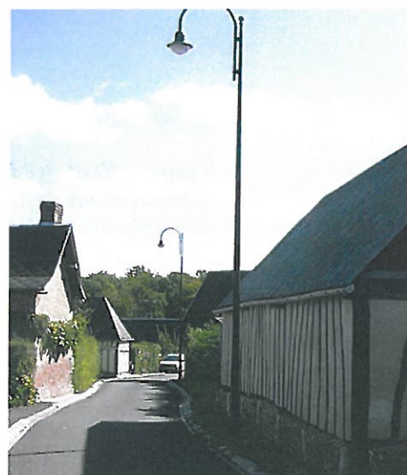
Figure 32 : Eclairage public sur la Rue de la Mare Curée
