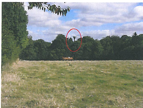
Figure 32: Vue sur la lisière des bois du Vallon de la Haye et Château d'eau de La Neuville du Bosc en point d'appel du regard
