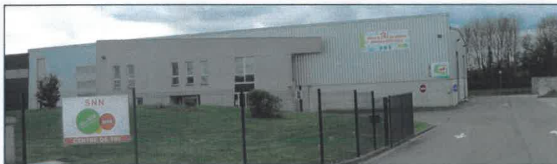
Centre de tri des déchets recyclables d'Étrépagny
