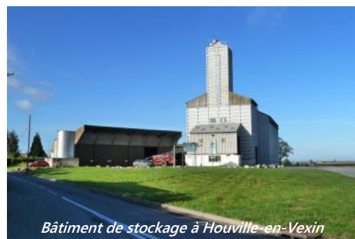
Bâtiments agricoles bien intégrés à Houville
