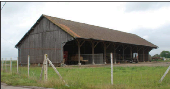
Hangar traditionnel en bardage de bois et couvert de tuile.
