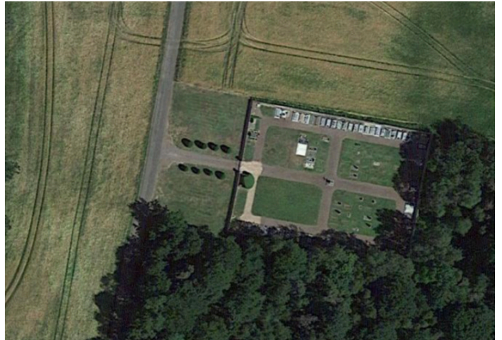
Cimetière : Zone enherbée devant le cimetière, stationnement d'une capacité d'environ 30 places non balisées
