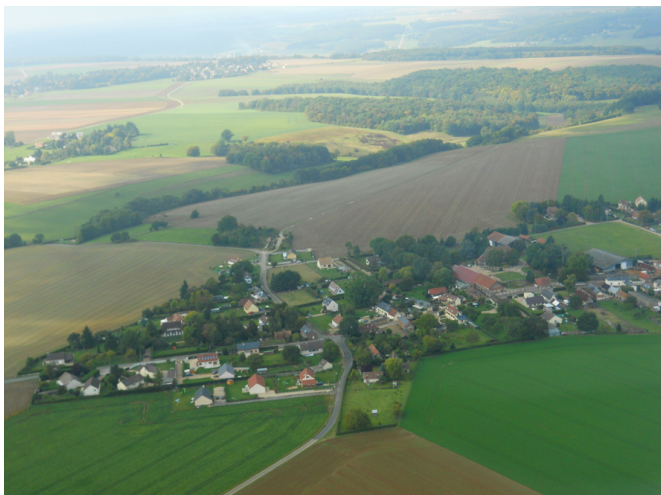
Vue Gaillardbois depuis le Nord
