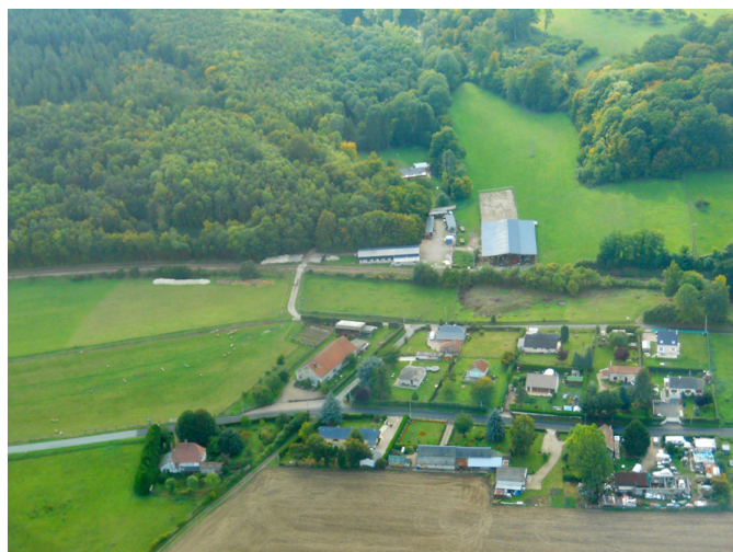
Vue urbanisation en vallée de Fouillebroc
