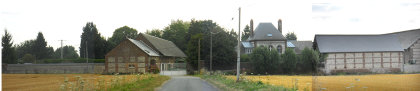
Vue depuis VC 49 – entrée de Cressenville
