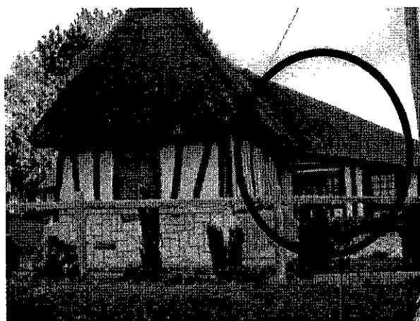
Extension à la construction principale
