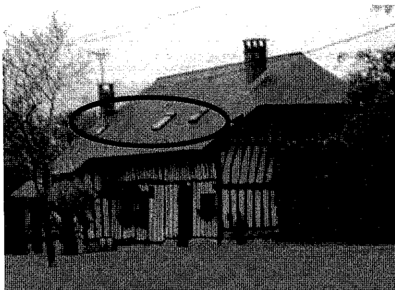
Fenêtres de toit : ouvertures discrètes faites dans le toit d'une construction ancienne, permettant de rendre habitable la surface située sous les toits
