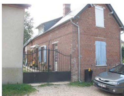
Alignement du pignon
