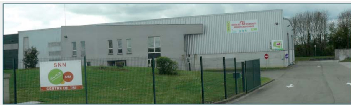
Centre de tri des déchets recyclables d'Étrépagny
