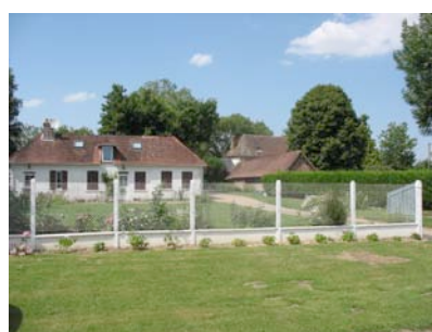
À Neuville, bâti ancien en retrait
