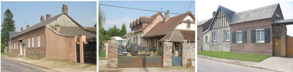
Formes simples du bâti ancien : volumes rectangulaires surmontés de toitures à double pente, bâtiments accolés.
