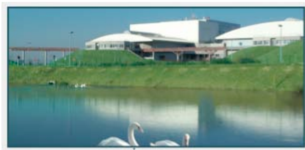
L'usine d'incinération de Guichainville
