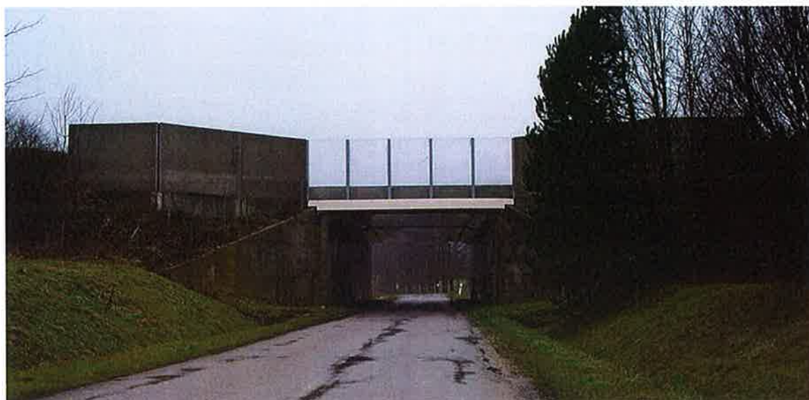
Passage de la VC1 sous l'autoroute A13 et vue sur le mur qui « protège » le Village
