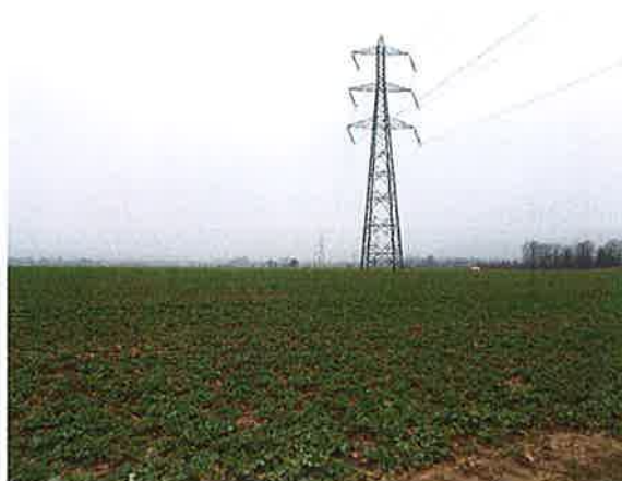
Les lignes électriques haute tension qui défigurent le plateau
