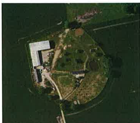
Vue aérienne sur le clos mesure de la Ferme de Vienne où les alignements d'arbres viennent d'être replantés et la maison de maître restaurée...
