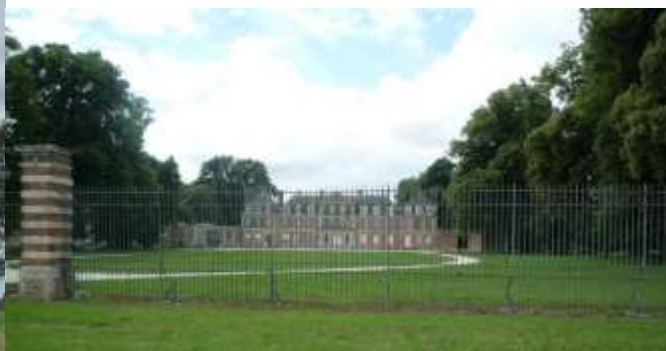
alignement d'arbres au château
