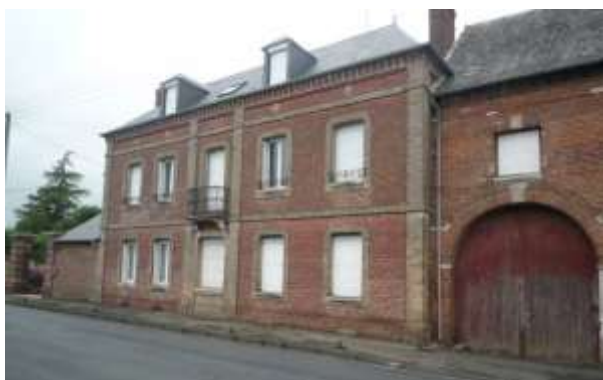
Extension Ouest chaussée Nord
