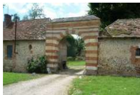
Porche du château en pierres de taille et briques
