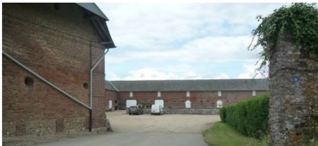
Ferme cadastrée D72 (Villerest)
