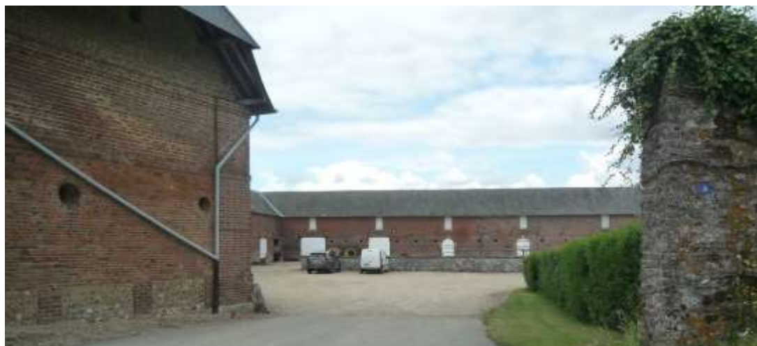
Ferme cadastrée D72 (Villerest)
