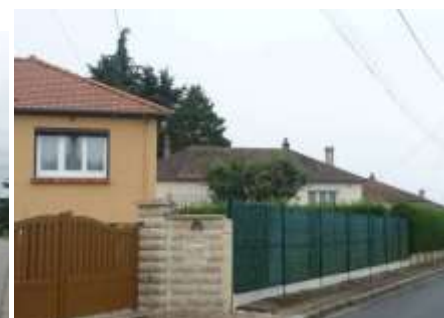
Route de Fresne l'Archevêque
