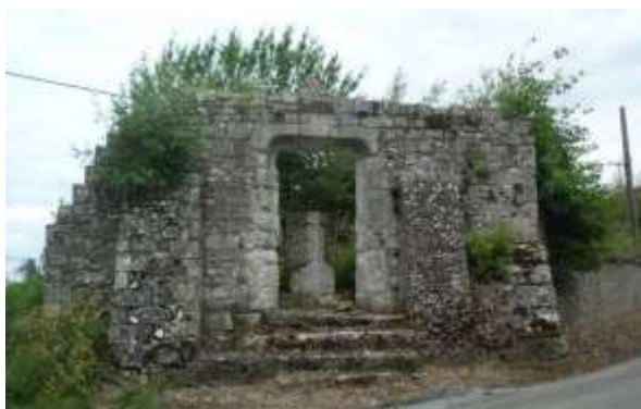
Vestiges de l'église Saint-Martin
