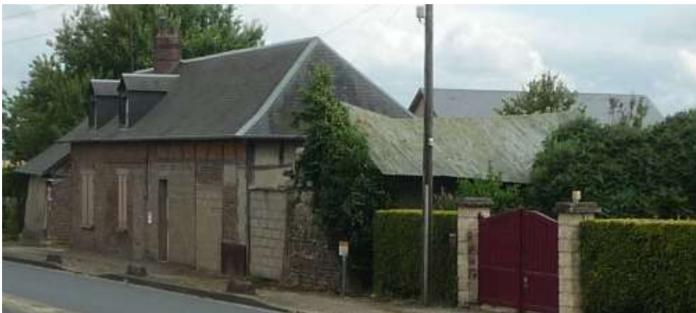
annexe d'habitation en tôle ondulée
