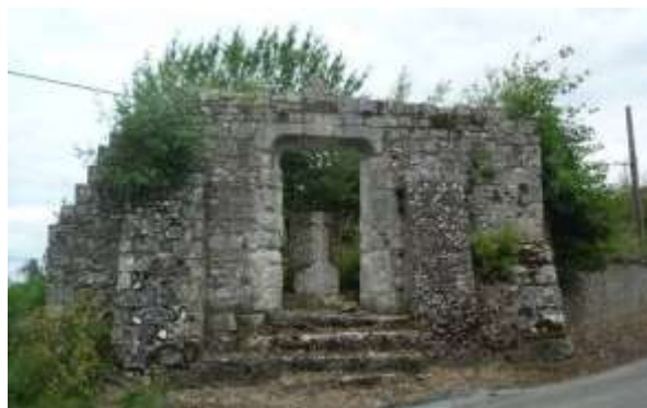
Vestiges de l'église Saint-Martin
