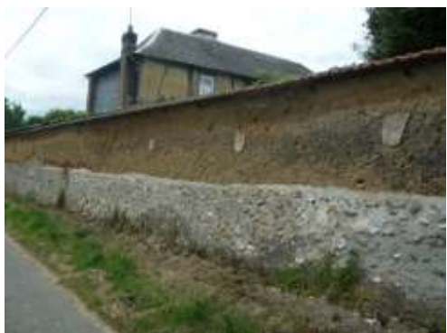
Mur en pierres et torchis à Villerest
