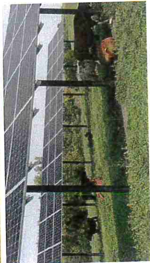
Exemples d'implantation agrivoltaïques permettant le maintien de l'activité agricole (culture, élevage...)
