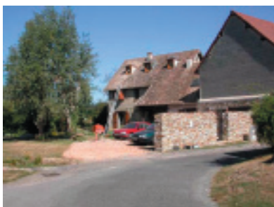
B 9 Maison ancienne en cours de restauration
