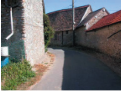
C 1 Entrée ouest de Gournay chemin rural n° 5
