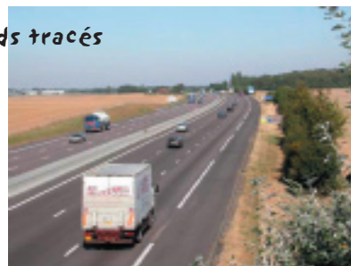
A 14 L'autoroute A 13 depuis le pont au hameau des Hayes
