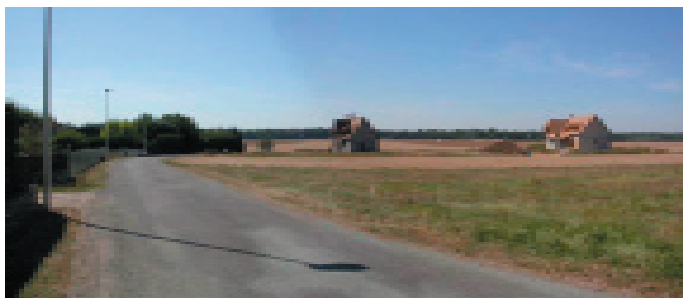
E 6 Il manque un accompagnement végétal à ces maisons récentes à l'entrée du village rue de la Plaine
