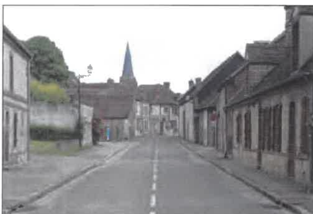
L'habitat traditionnel du pays d'Ouche joue sur les contrastes entre les enduits clairs, ocrés et les couleurs sombres des toiles et des entourages de toiles en brique. (2009 - commune de Chemehébrun)
