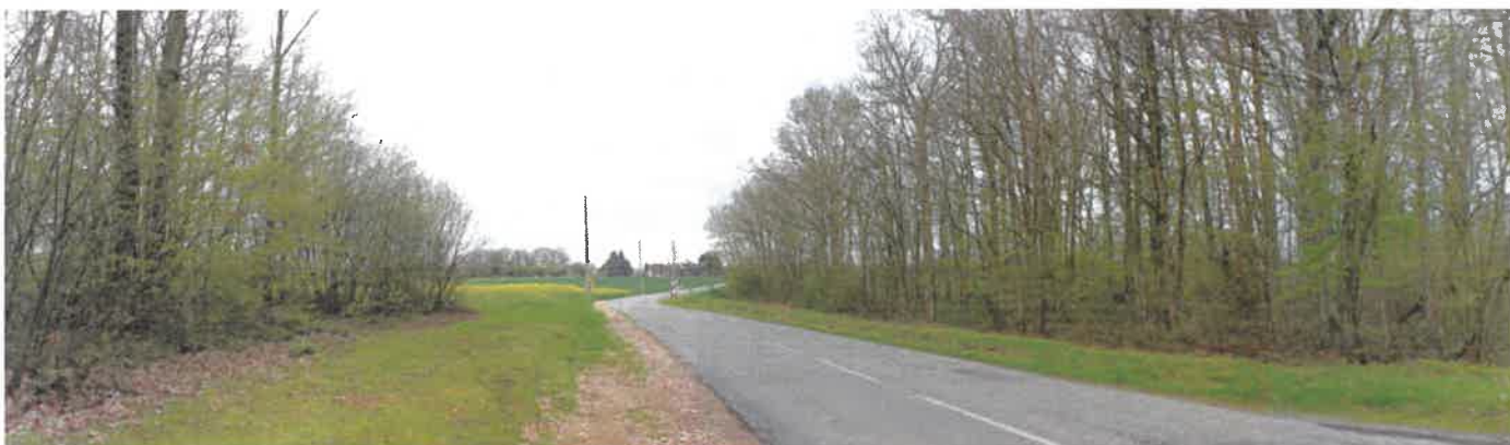
Vue depuis la RD 167 (Glisolles) en direction de la Haute Croisille
