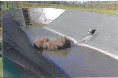
bassin de rétention
