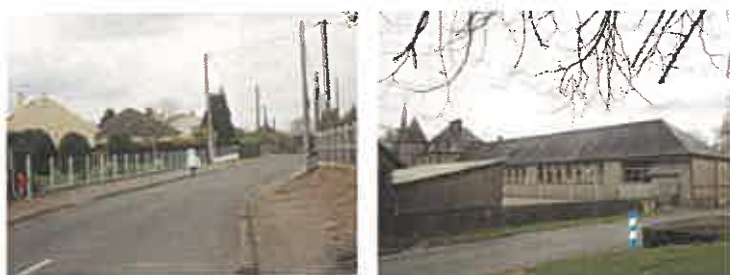
Réalisation progressive de quelques cheminements piétons pour relier les espaces urbanisés au sein du centre-bourg mais qui manque de continuité
