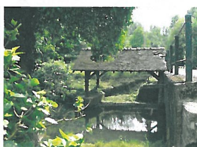
lavoir de Provemont
