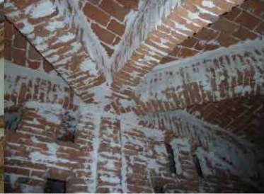
Les voûtes en briques des communs
