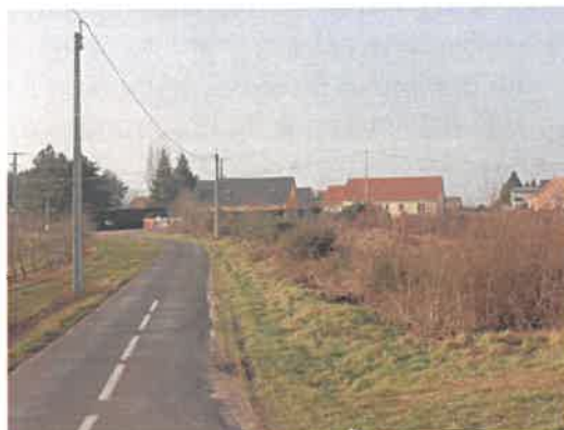
Nouvelles constructions dans le hameau du Breuil
