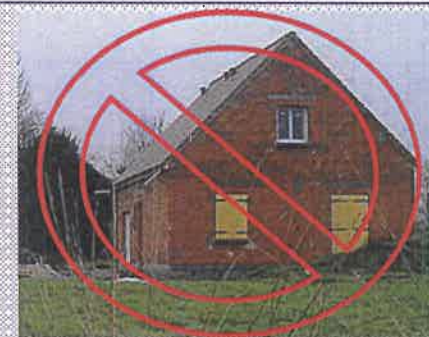
Briques creuses laissées nues à éviter
