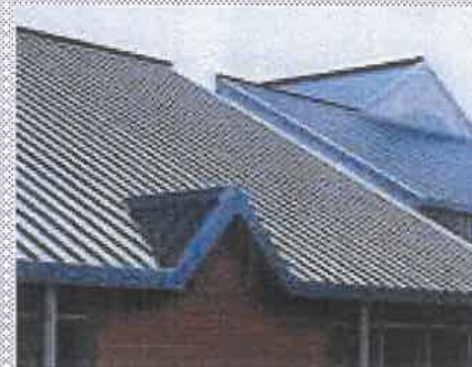
Couverture en bac acier (à l'instar de la Salle des Fêtes)
