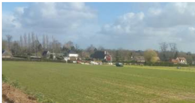
Photo du chantier de comblement 09 03 2020
