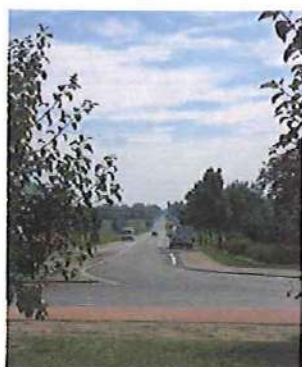
Entrée Nord de la D 313 aménagée
