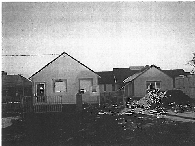
Figure 17: Equipements scolaires en travaux en 2008
