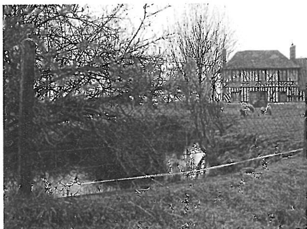
Figure 37 : Ancienne fermette au hameau des Poulets (R+1+C) à pans de bois et toiture à 4 pans en ardoises
