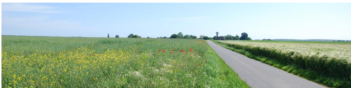
Figure 19 : Visibilité du château d'eau, dans cet espace plan
