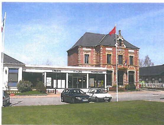
Façade de la mairie, ensemble et détail
