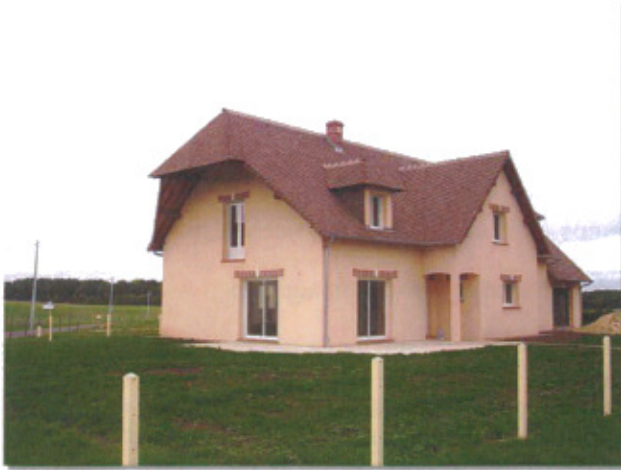
Bâti récent au niveau du bourg
