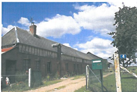
Maison en briques et colombages
