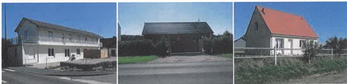
Utilisation de matériaux standardisés et implantation systématique en centre de la parcelle
