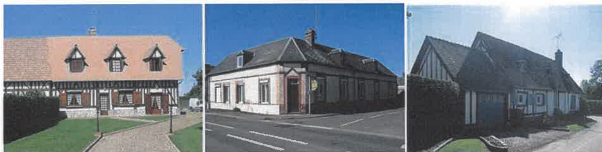
Harmonie des matériaux et des teintes dans le bâti ancien
