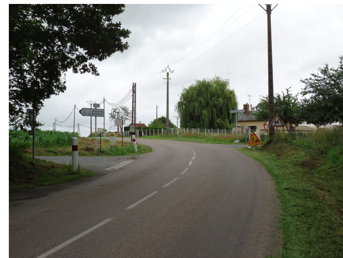
▲ RD 28 et ses abords à l'intersection de la rue du petit bois (à droite)
