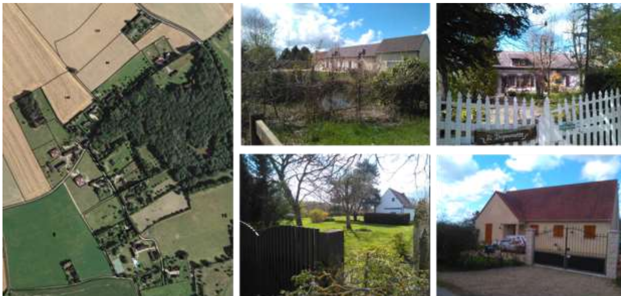
Un habitat en bordure de forêt caractérisé par une implantation globalement en milieu de parcelle
