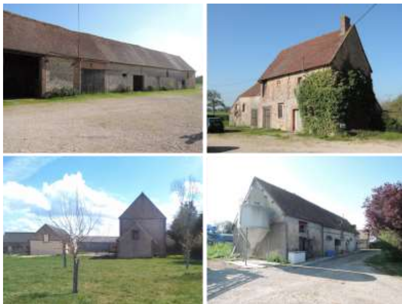
Exemple de bâtiments identifiés
